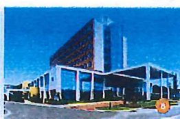
社会医療法人財団 池友会 福岡新水巻病院 〒807-0051 遠賀郡水巻町立敷1-2-1 Tel. 093-203-2220 / 227床(急性期) 平成15年6月開院/院長 藤井 茂 セラピスト数: 82名 / 看護師数: 352名 延床面積: 19,519㎡(2,504坪)
