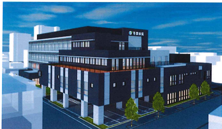
等潤メディカルプラザ病院 2023 年 9 月開設
